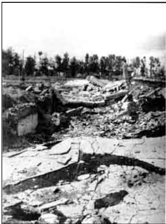
Fotografia 2 La copertura di cemento armato del Leichenkeller 1 del crematorio II di Birkenau nel giugno-luglio 1945 Fotografia di Stanisaw Kolowca
