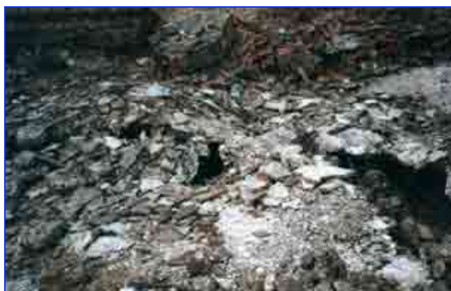
Fotografia 31 Copertura di cemento armato del Leichenkeller 1 del crematorio II di Birkenau. Agosto 2000. Apertura 8 (al centro) e continuazione della frattura di cui essa fa parte. © Carlo Mattogno (click picture for blowup)
