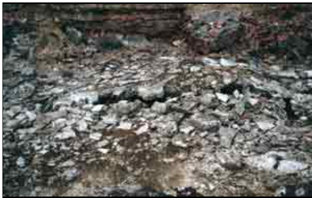
Fotografia 30 Copertura di cemento armato del Leichenkeller 1 del crematorio II di Birkenau. Agosto 2000. © Carlo Mattogno
