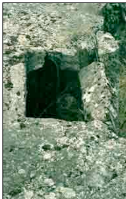
Fotografia 10 Solaio della sala forni del crematorio III. Seconda apertura di ventilazione (da ovest) Giugno 1990. © Carlo Mattogno
