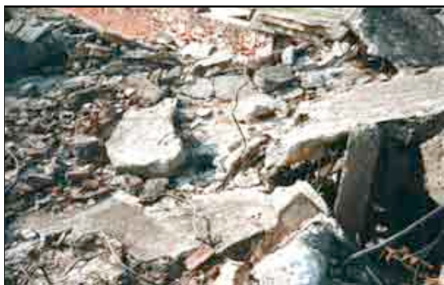
Fotografia 6 Apertura rotonda per il tubo dell'impianto di disaerazione ( Entlüftung ) sulla copertura di cemento armato del Leichenkeller 2 del crematorio II di Birkenau. Agosto 2000. © Carlo Mattogno
