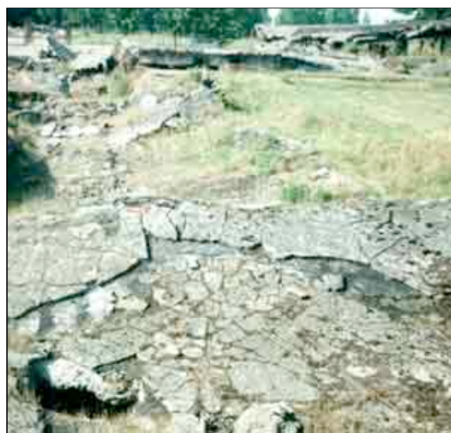
Fotografia 3 La copertura di cemento armato del Leichenkeller 1 del crematorio II
